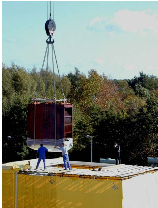
Abbildung 109: Einbau der neuen Wicklung für die Summendrossel.
