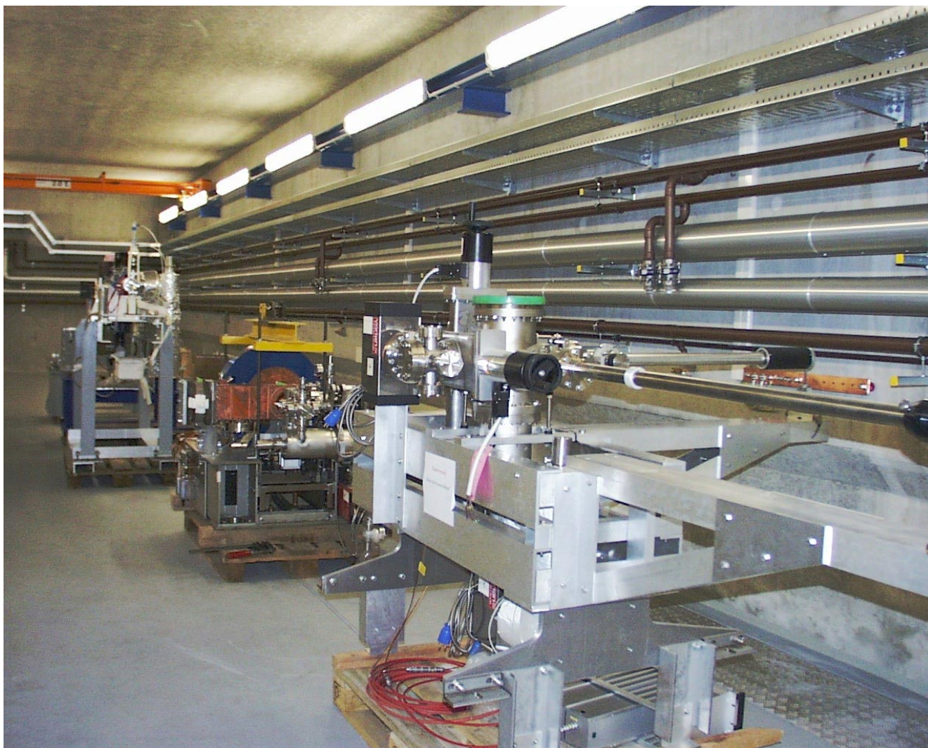
Abbildung 85: Stand des Aufbaus des PITZ-Injektors.
