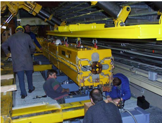
Abbildung 133: Einbau der Quadrupolmagnete Typ GN.
