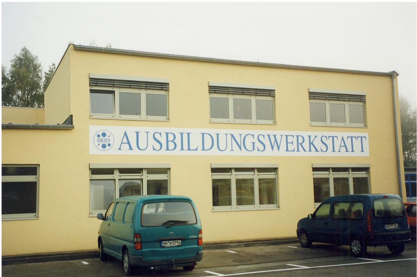
Abbildung 127: Anbau der Ausbildungswerkstatt.
