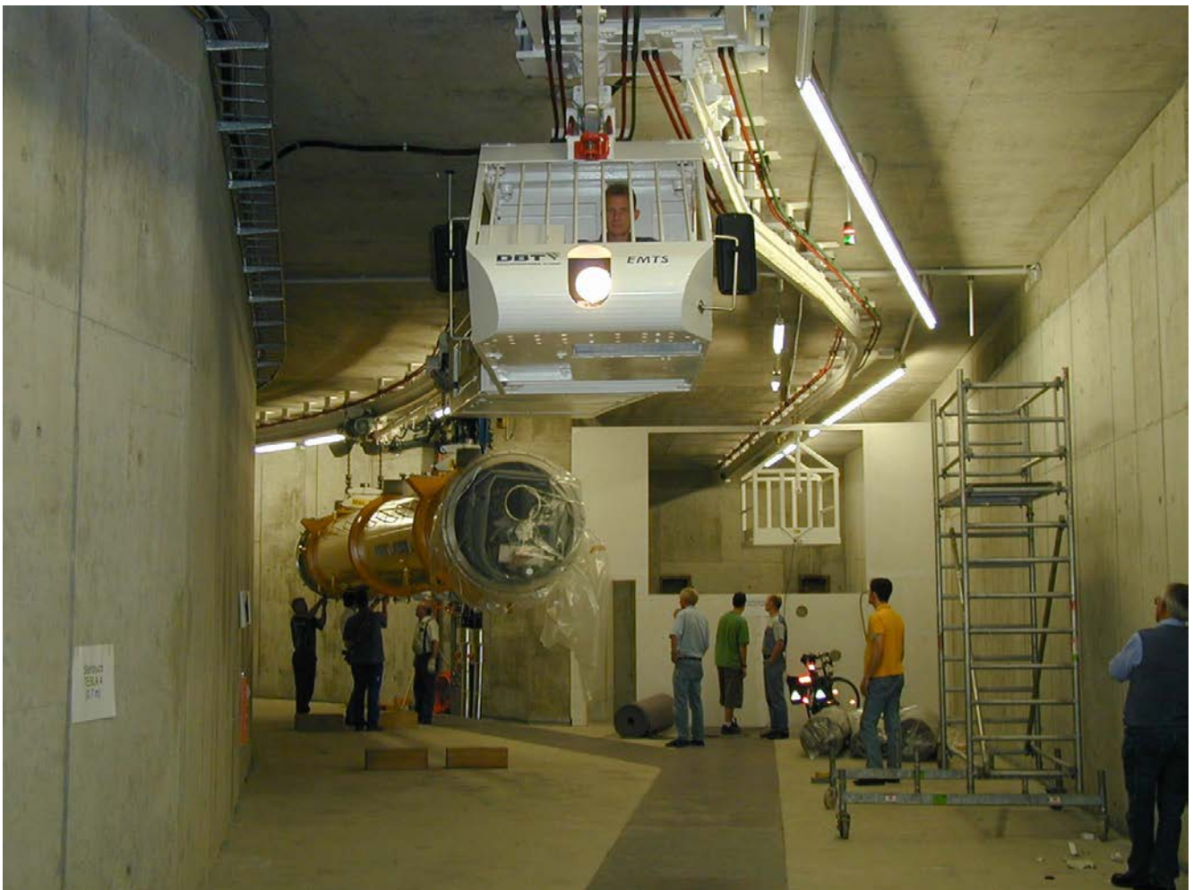
Abbildung 128: Einbau eines Beschleunigermoduls im TTF-Tunnel.
