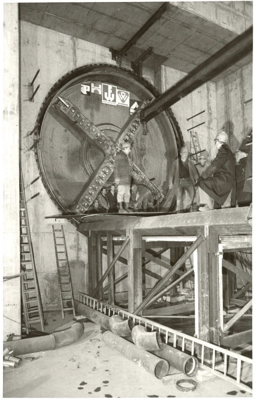
Abbildung 9.10 Die Tunnelbohrmaschine trifft, nach ihrem 6,3 km langen Weg, im August 1987 genau an der vorgesehenen Stelle wieder in der Experimentehalle Süd ein (DESY-Archiv).
